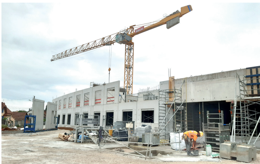
Vue du chantier.
