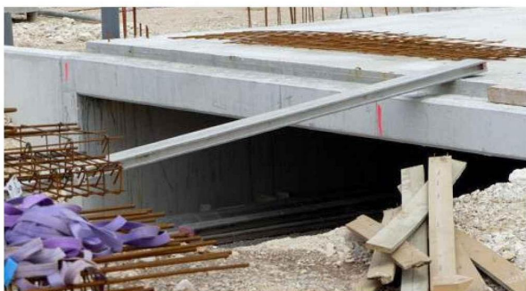
Pour permettre à l'eau de ne pas être bloquée par la future résidence, en cas de crue de la Savoureuse voisine, l'architecte a prévu des carneaux sous une partie de l'Ehpad. Ces zones d'infiltration éviteront d'inonder les habitations voisines.
